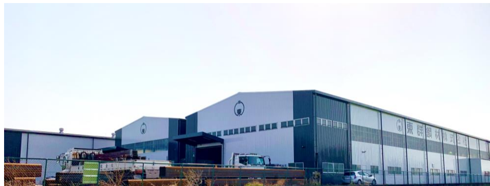
本社倉庫・加工工場（群馬県玉村町）
