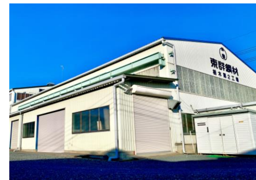
栃木第二工場（栃木県栃木市）
